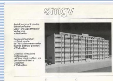
Neues Ausbildungszentrum in Wallisellen 1971
